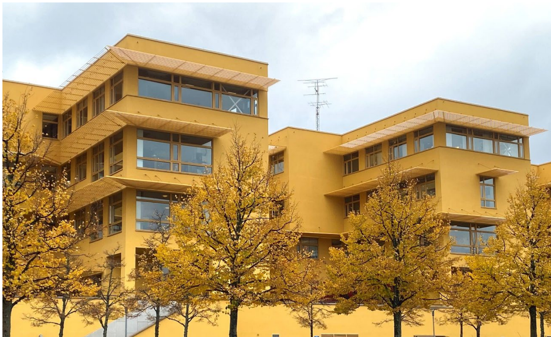
Bild: Tekniska Högskolans nymålade fasad
